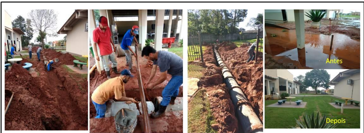
Tubulação para Drenagem de Águas Pluviais
