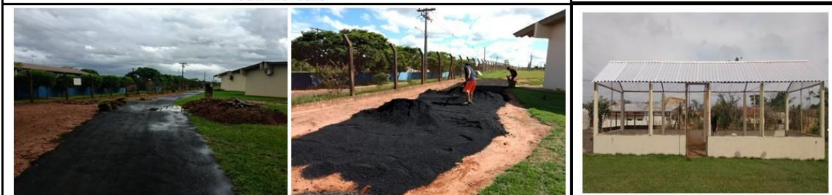
Pavimentação da Entrada Lateral
